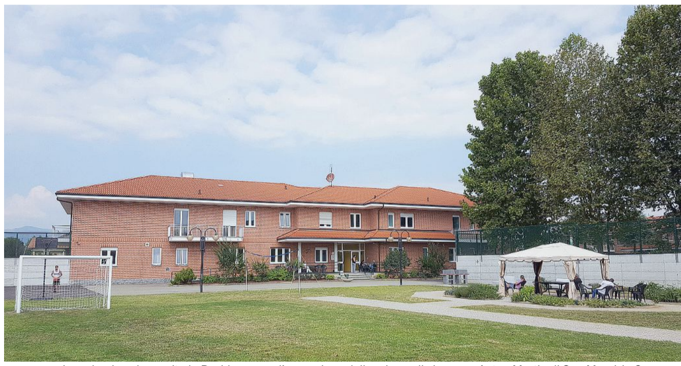
La palazzina che ospita la Residenza per l'esecuzione delle misure di sicurezza Anton Martin di San Maurizio Canavese
