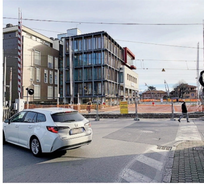
Il passaggio a livello chiuso per lavori in corso 25 Aprile
